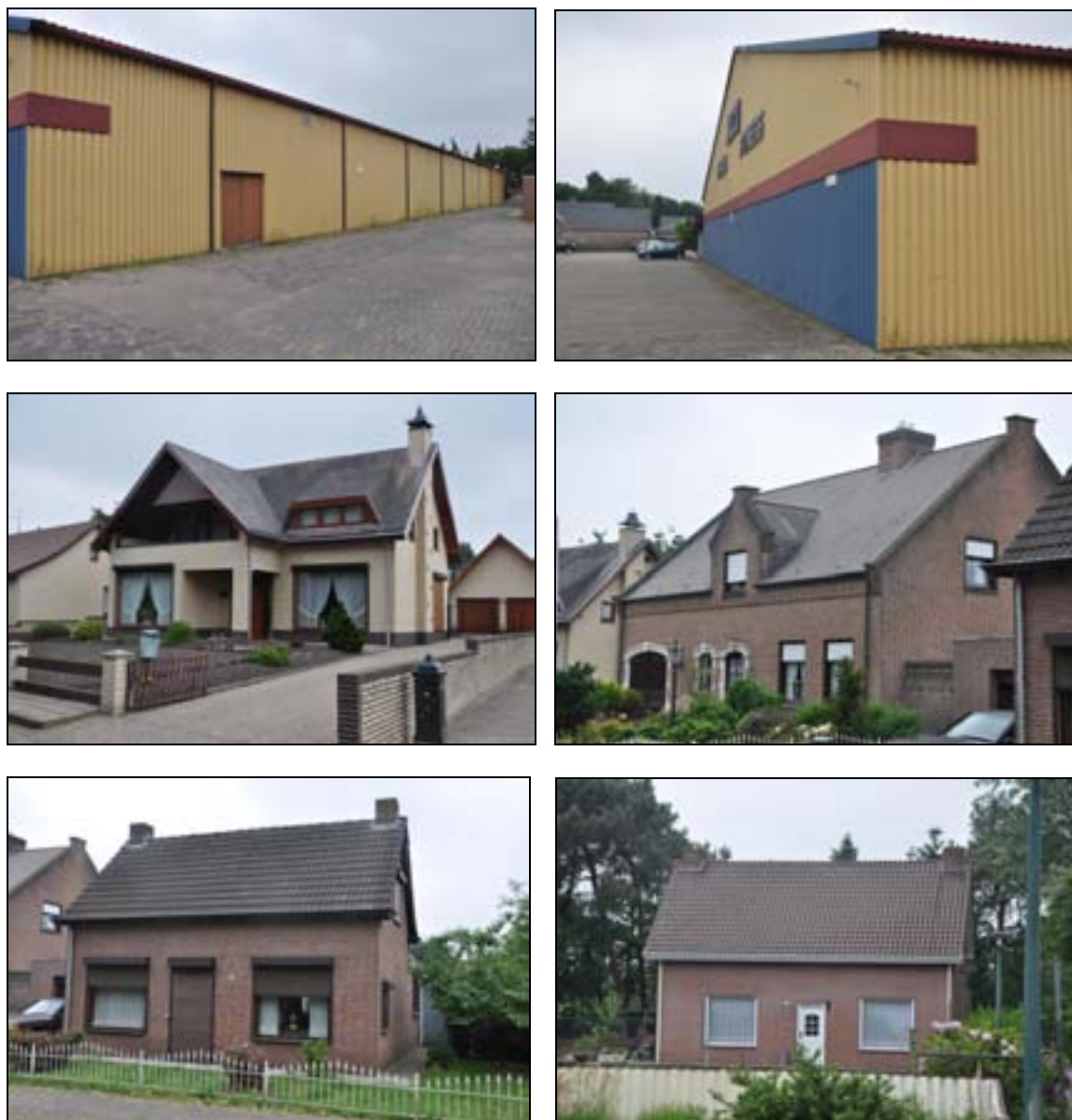
Figuur 2. Foto-impressie van te slopen / beïnvloede bebouwing.
